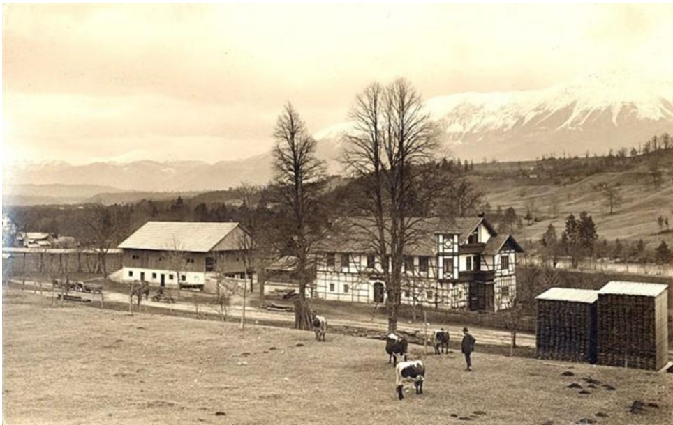
Remčeva hiša, ok. 1930 Vir: arhiv družine Remec
